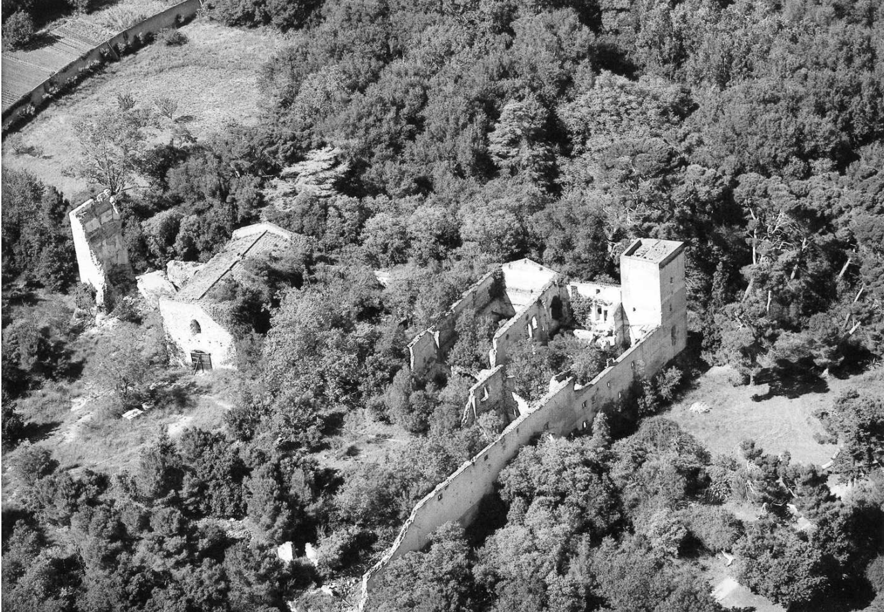
Fig. 3 : Vue aérienne de la commanderie du Masdéu. Cliché ECSA-Jamin.
