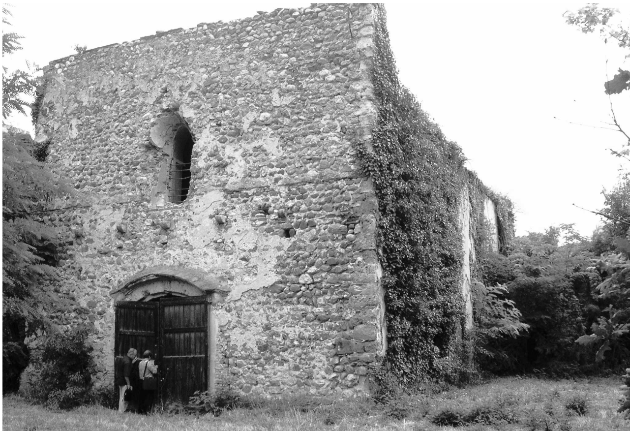
Fig. 4 : Vue de la façade ouest de l'église Sainte-Marie du Masdéu. Cliché R. Tréton.
